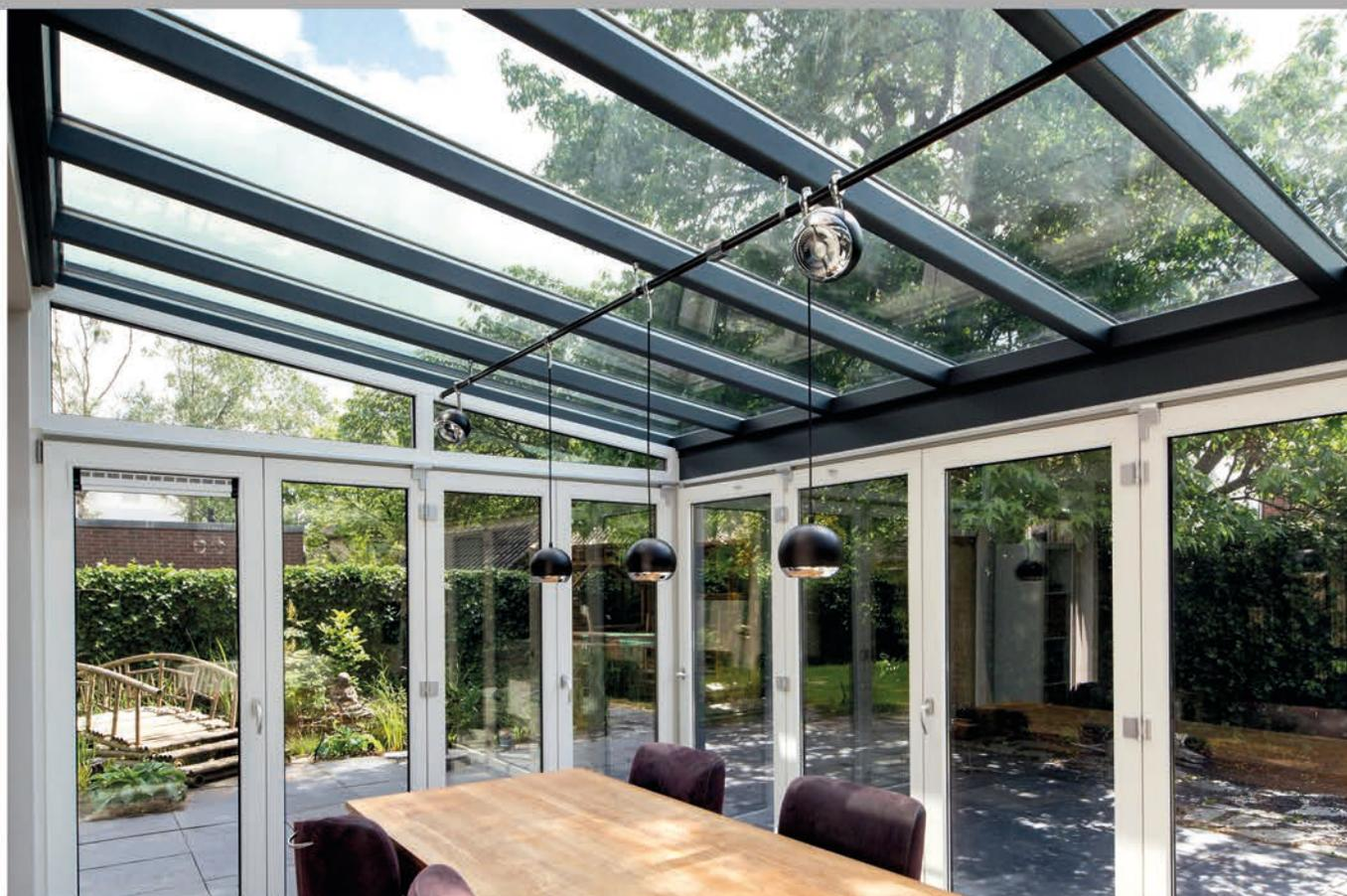
Le système de toiture autoportante en aluminium avec coupure thermique offre de nombreuses combinaisons possibles. Les lignes arrondies, les formes douces et les matériaux de haute qualité confèrent à ce système une classe inédite.
