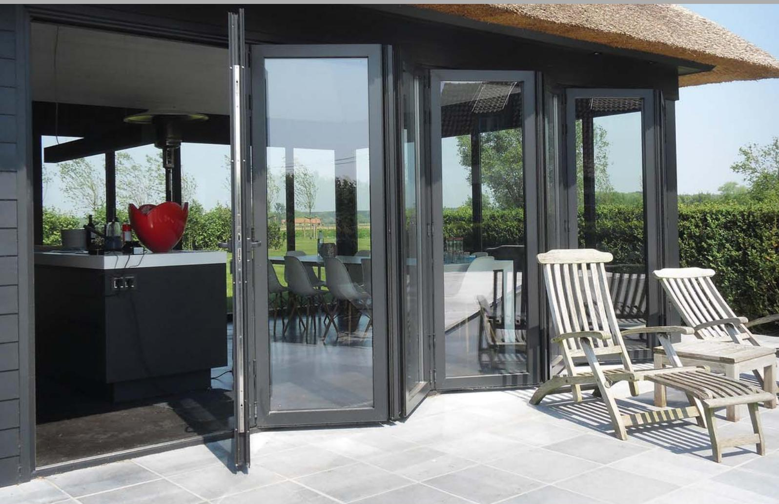
Le système de porte repliable ou de cloisons pliantes à coupure thermique vous permet de créer de larges passages. Dans le cadre dormant, on place des éléments pliables qui peuvent se déplacer soit vers la gauche, soit vers la droite. Montage d'un mauclair possible afin d'offrir plus de stabilité dans chaque situation.
